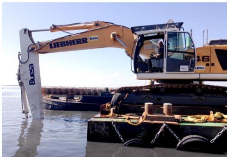
Figure 3 : Atelier ponton-pelle utilisé lors du dragage du Mourre Blanc (CISMA Environnement, 2017)
